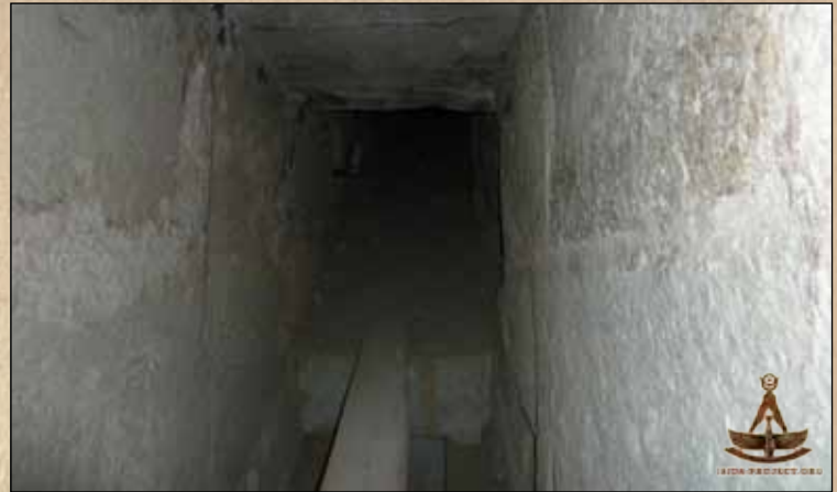
Западный Нисходящий Коридор (вид от западной порткулисы)
