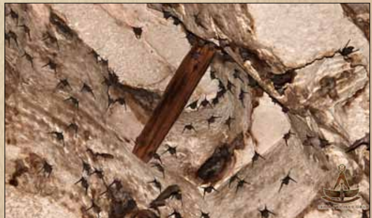
Балка под потолком Верхней Камеры
