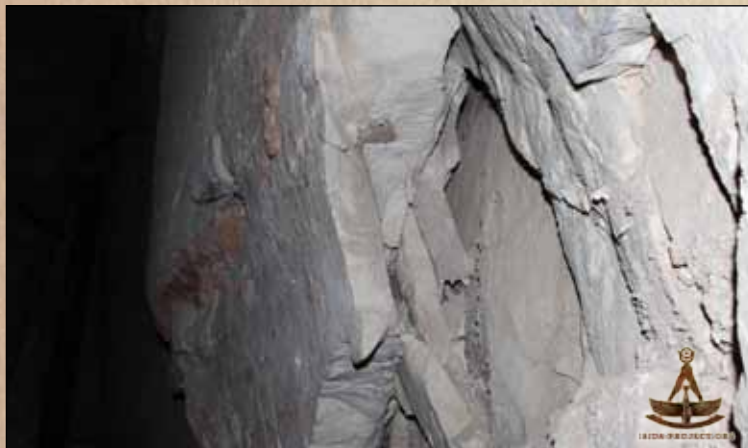
Разрушения Нижней Камеры
